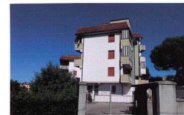
Foto 1 VISTA DELL'ACCESSO PRINCIPALE DA VIA G. MATTEOTTI
