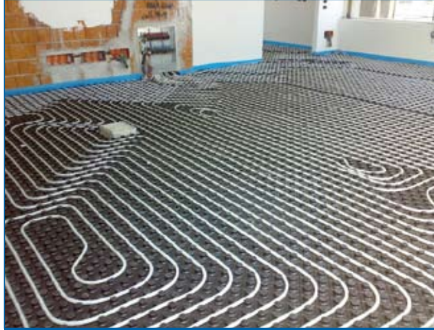
La posa di un moderno impianto a pavimento
